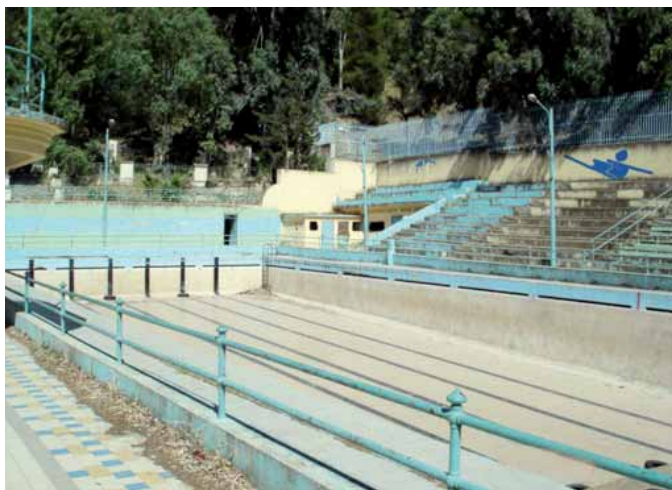
Une enveloppe de 180 millions de dinars a été allouée pour réparer les dégâts
