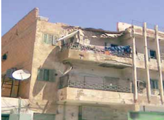
L'immeuble ayant été le théâtre d'une explosion d'un compteur électrique
