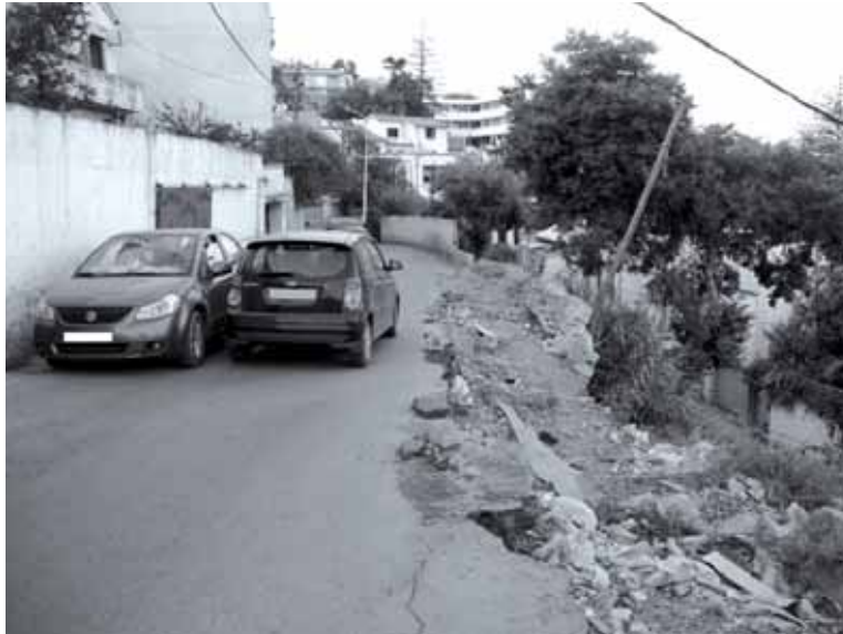
La chaussée s'est rétrécie au chemin Laperlier, à Alger-Centre
