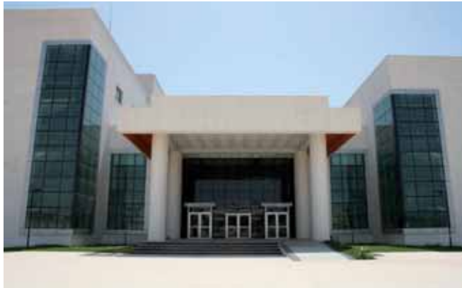
Le nouvel hôpital de 240 lits est le premier du genre à être construit à Chlef après le séisme de 1980
